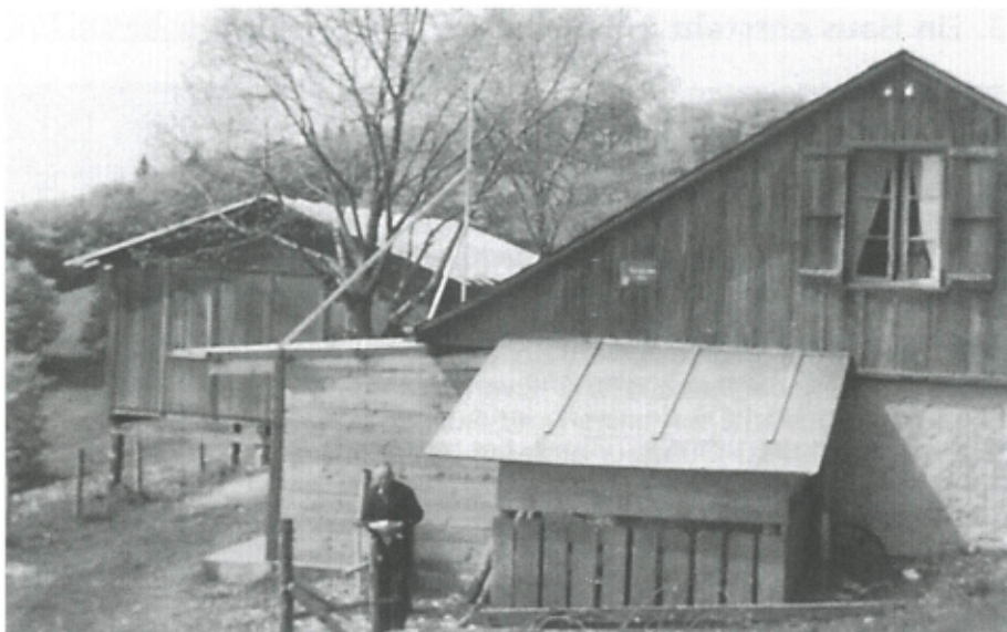
Alte Alphütte und Baubaracke (Frühjahr 1980)
