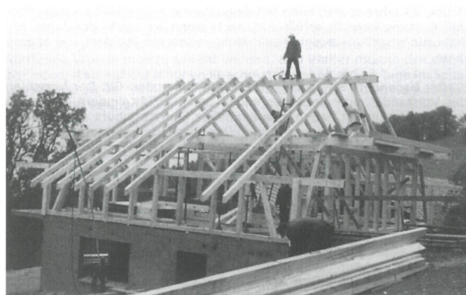
Kurz vor dem Aufrichten (18. Oktober 1980)
